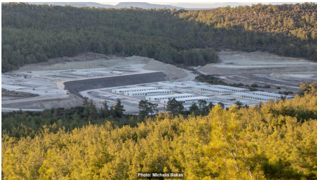
Η υπό κατασκευή νέα ΚΕΔ στη Βάστρια
